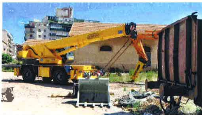
UNO DEI TANTI CANTIERI FERMI A PALERMO
